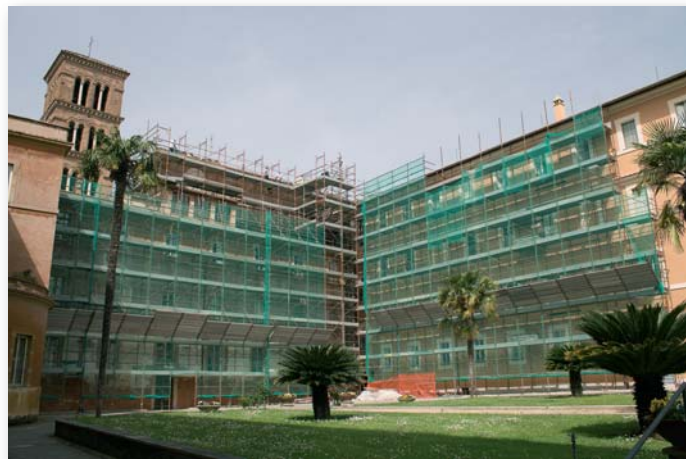
Ristrutturazione del settore "casa" del convento dei SS. Giovanni e Paolo.
