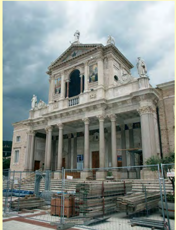
La chiesa antica di S. Gabriele con le impalcature per il lavoro di riparazione.
